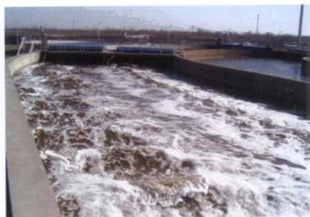
图43-32 \Phi 1400 转盘应用在辛集污水处理厂 (10万吨/天)
