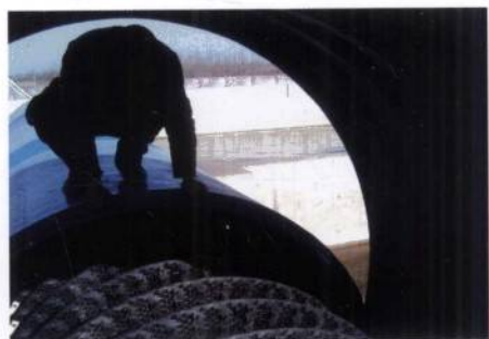
图43-31 工作人员在现场安装调试
