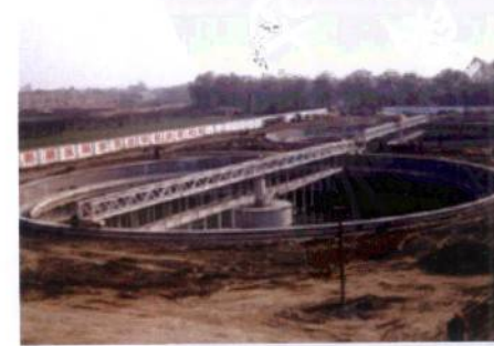
图43-38 铝合金桥架的刮泥机应用于河南周口市污水处理厂
