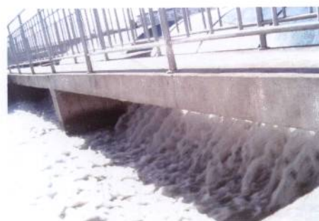
图43-33 侧视的曝气效果
