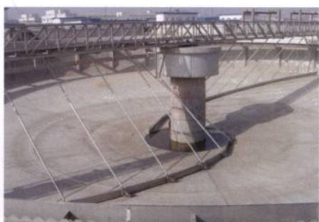
图43-20 刮泥桥全貌
