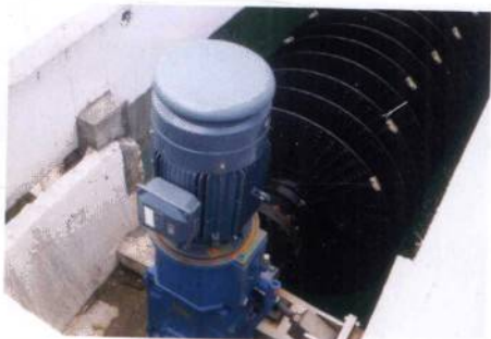
图43-39 选用弗兰德减速机应用与安徽六安污水处理厂（8万吨/天）
