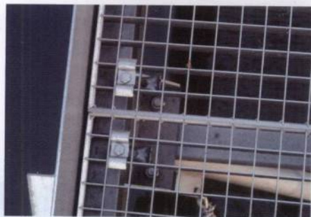
图43-29 刮泥桥的走道方格栅板
