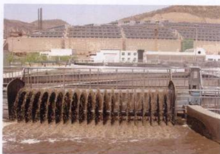
图43-24 \Phi 1400 转盘曝气推流效果（后端视图）
