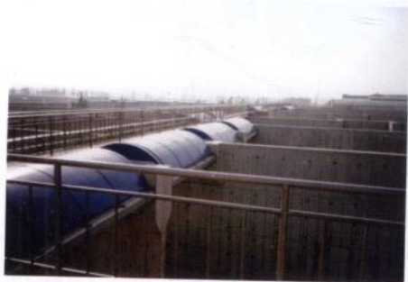
图43-41 玻璃钢防护罩安装于Orbal氧化沟系统
