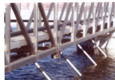
图43-37 全不锈钢的工作桥架
