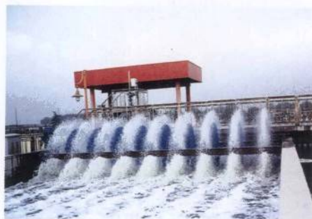
图43-26 \Phi 1800 转盘曝气效果（前端视图）
