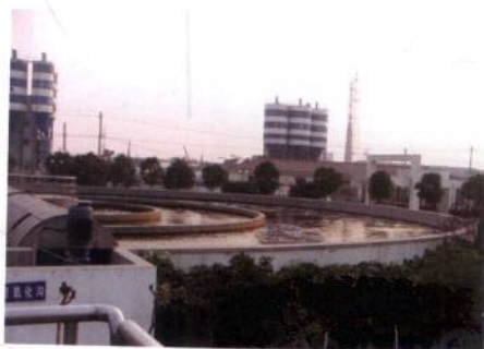
图43-44 无锡城北污水处理厂中央岛设厌氧系统的Orbal氧化沟（一期、二期共计10万吨/天）
