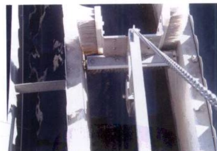
图43-36 刮泥桥的毛刷工作状态
