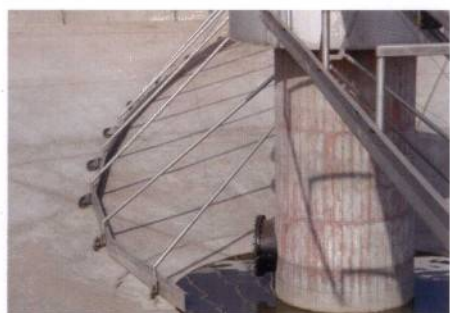
图43-17 Orbal氧化沟二沉池，圆弧形刮泥板部分
