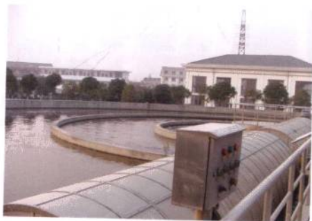
图43-43 应用于无锡城北污水处理厂的不锈钢防护罩
