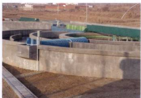
图43-21 中间带二沉池的Orbal氧化沟 (应用于烟台某食品废水)
