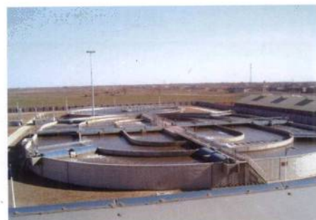
图43-34 Orbal氧化沟应用在济源污水处理厂 (5万吨/天)
