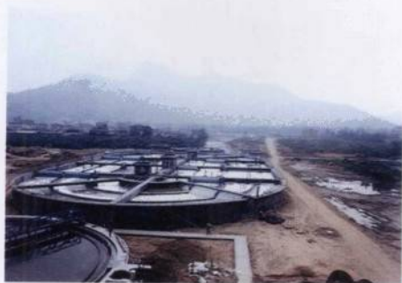
图43-27 Orbal氧化沟应用于温州水头二号工程（处理3万吨/天的皮革废水）
