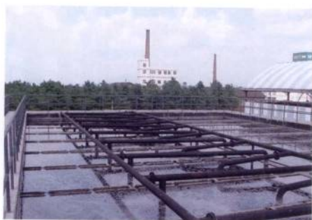
图43-11 Orbal氧化沟预处理使用的UASB反应器沼气收集系统，应用于山东龙大集团， 6000\text{m}^3/\text{d}
