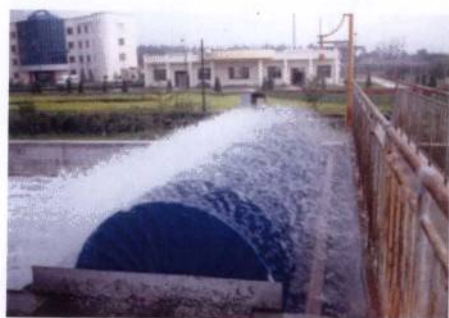
图43-13 \Phi 1800 转碟曝气机应用现场
